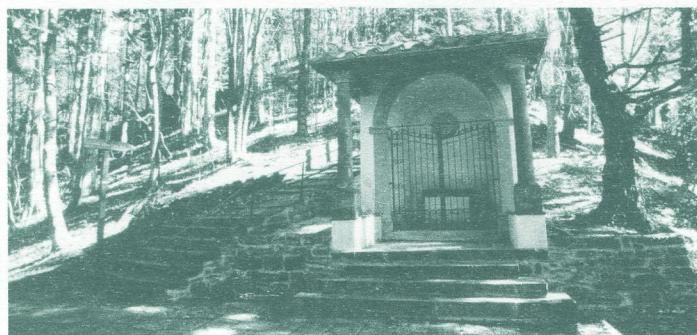
La cappella delle Colonne dopo il restauro
